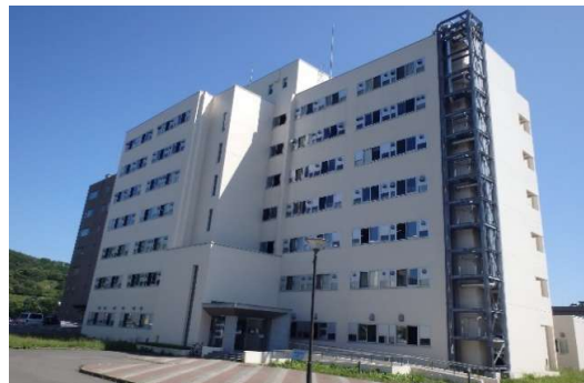
室蘭工業大学総合研究棟（機械航空創造系）
